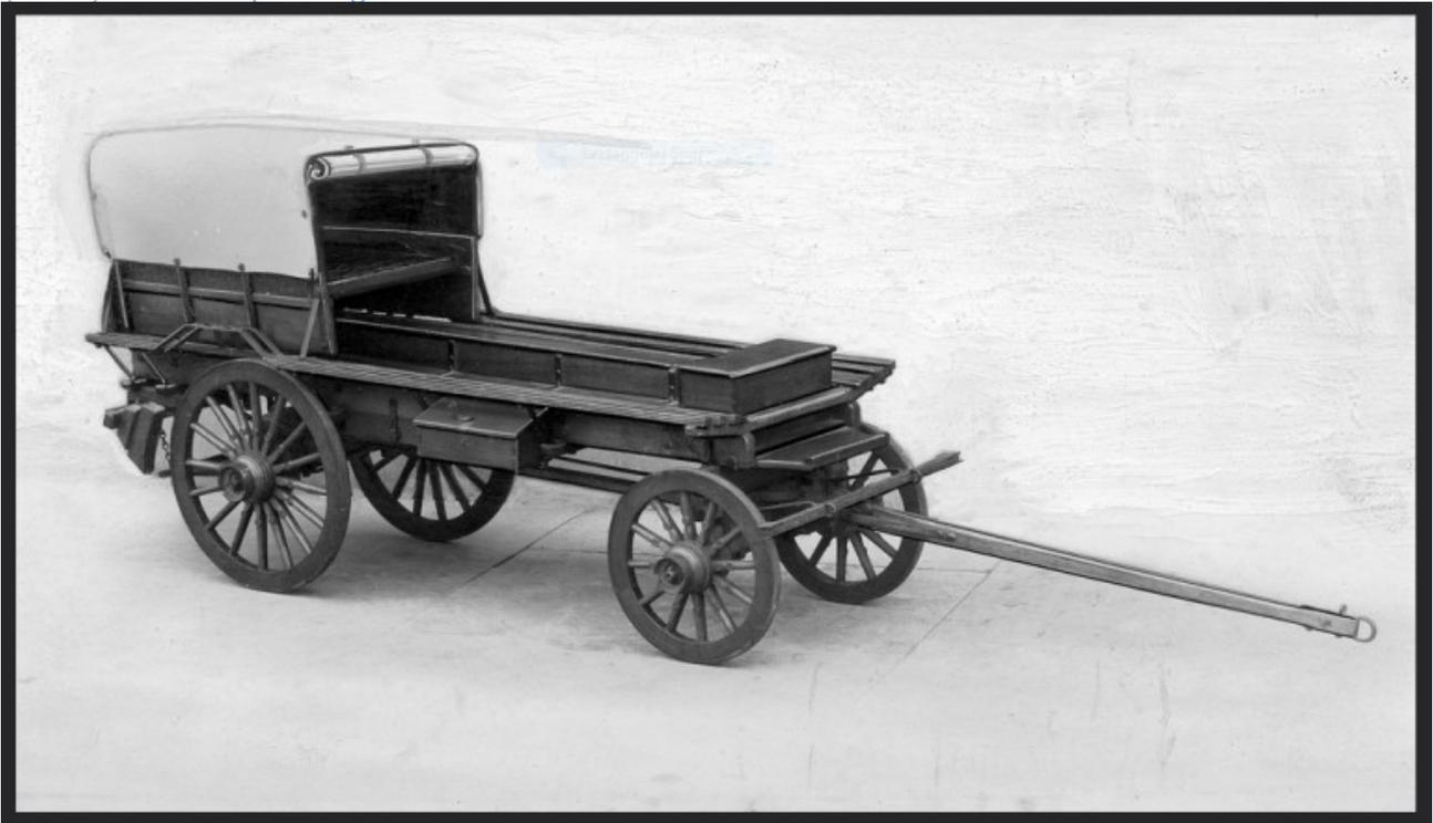
Diese Wagen waren mit Holzblock-Bremsen ausgestattet, um die Betriebssicherheit zu erhöhen. Sie wurden so massiv gebaut, dass sie bis zu 5 Tonnen transportieren konnten. Sie haben das südliche Afrika für Industrie und Staatswesen erschlossen. Aber der Transportwagen ist eine andere Geschichte für sich, eine andere Veröffentlichung für einen anderen Tag.
